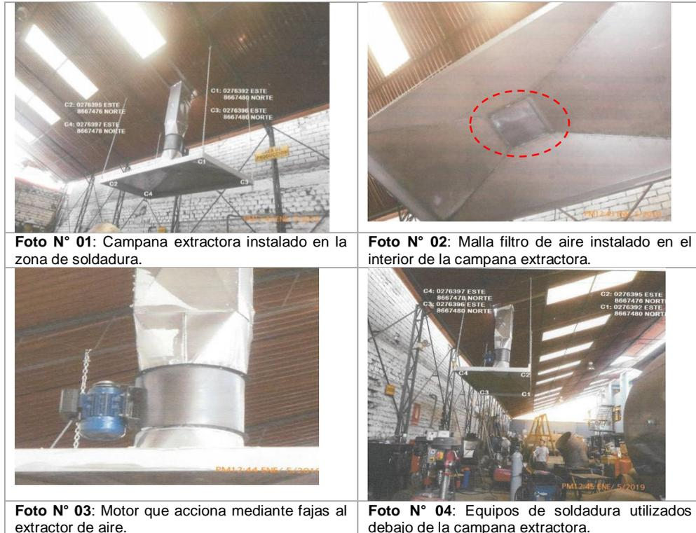
75. Por otra parte, de las fotografías se aprecia que el administrado ha implementado una campana extractora, la cual cuenta con los siguientes componentes: ducto de metal, campana de metal, moto reductor y filtro en el interior de la campana.
