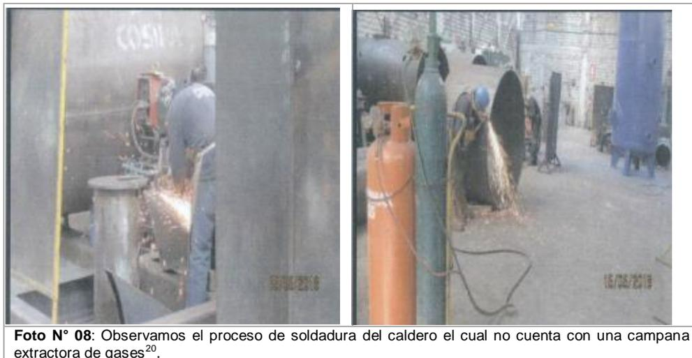
32. Del análisis de las fotografías se advierte que el personal de la Planta Cercado de Lima se encontraba realizando acciones de soldadura durante la Supervisión, no obstante, en dicha área no se evidenció que se haya implementado el compromiso asumido en la DIA.
