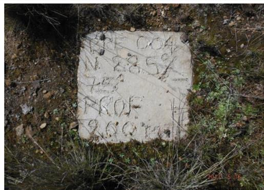
**Fotografía N° 2 del panel fotográfico:** Vista del dado de concreto ubicado en la Plataforma P-19. El dado de concreto contenía la información del sondaje realizado en la plataforma en mención.
