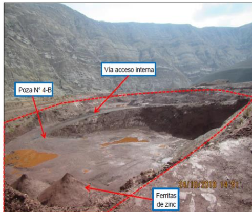
Fotografía N° 4: Vista panorámica de la Poza N° 4-B, donde se observaba que el contenido de las ferritas de zinc ha disminuido.
