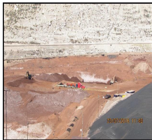
FOTOGRAFÍA N° 99: Depósito de Ferritas de Zinc de Huanchán. Otra Vista del interior de la poza 4A, donde se aprecia el movimiento de material mediante el uso de excavadoras. Asimismo, se observa que algunos tramos del dique de contención colindante con la vía de acceso se encuentran rotos.
