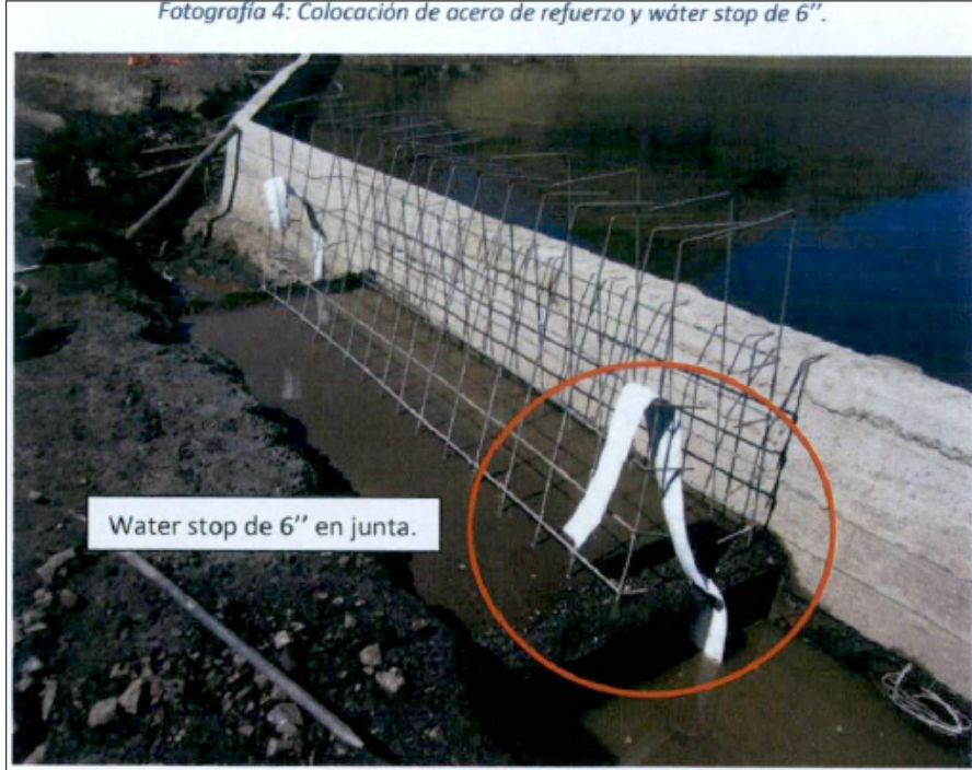
Fotografía 4: Colocación de acero de refuerzo y wáter stop de 6".
