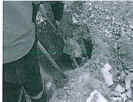
Foto 14: Plataforma PLT-4, durante el cierre del sondaje
