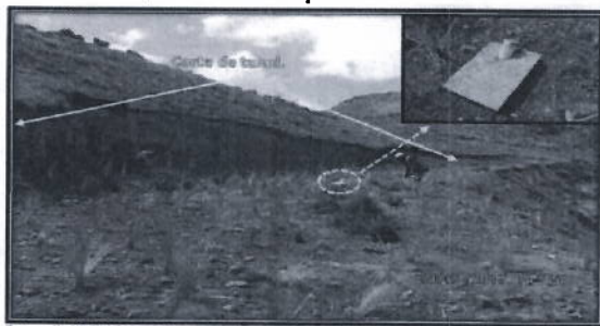
Fotografía N° 34: Presunto incumplimiento N° 02: Vista Panorámica de la Plataforma de perforación PLAT-17 (perteneciente a la DIA del proyecto Mario), ubicado en las coordenadas UTM WGS 84 – Zona 18: N 8 625 222, E 444 593 y altitud 4 640 m.s.n.m. Se observó un área de aproximadamente 20 metros de largo y 8 metros de ancho, con presencia de vegetación y la cual presentaba un corte de talud expuesto de aproximadamente 3 metros de alto. Asimismo, se observó un sondeje obturado a través de un dado de concreto y un tubo de PVC atravesado, con el código "MAR-18" y con fechas de inicio 18/02/12 y final: 19/02/12.
