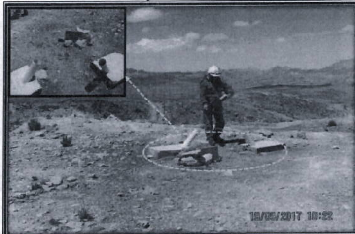
Fotografía N° 27: Presunto Incumplimiento N° 01: Vista Panorámica del área de sondaje sin identificación N° 4, ubicada en las coordenadas UTM WGS 84 – Zona 18: N 8 624 780, E 444 644 y altitud 4 783 m.s.n.m. Se observaron dos (2) sondajes obturados mediante dados de concreto y tubo de PVC atravesado, con las identificaciones "MAR-24" y "MAR-25". El área circundante contaba con material rocoso y no contaba con vegetación desarrollada.
