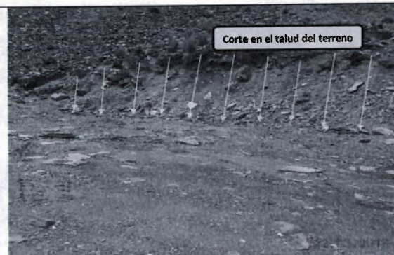
Fotografía N° 19. Vista del área de la plataforma P6. Presentaba dimensiones de 11,00 m de largo por 10,00 m de ancho. Dicha área no se encontraba rellena, perfilada ni revegetada, observándose el corte en el talud del terreno; asimismo, no se identificó afloramiento de agua ni evidencia de
