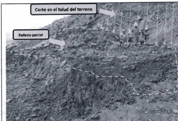
Fotografía N° 6. Vista del área de la plataforma P3, (coordenadas UTM WGS 84 Zona 18 E 387 350 N 8 698 672). Presentaba dimensiones de 15,00 m de largo por 12,00 m de ancho y un corte de talud expuesto de 3,7 m de altura, aproximadamente. Dicha área se encontraba rellena parcialmente, no se encontraba perfilada ni revegetada.
