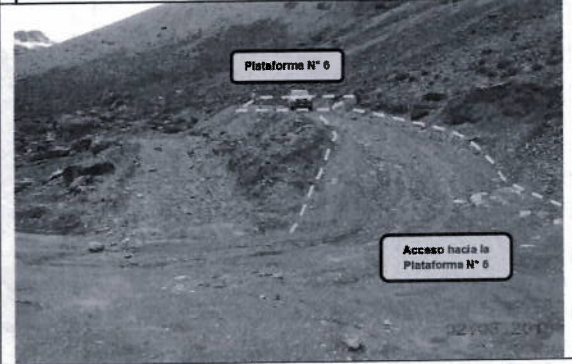
Fotografía N° 20. Vista del acceso hacia la plataforma P6, coordenadas UTM WGS 84 Zona 18, E: 387 534, N: 8 700 289. Tiene un ancho aproximado de 3,2 m.
