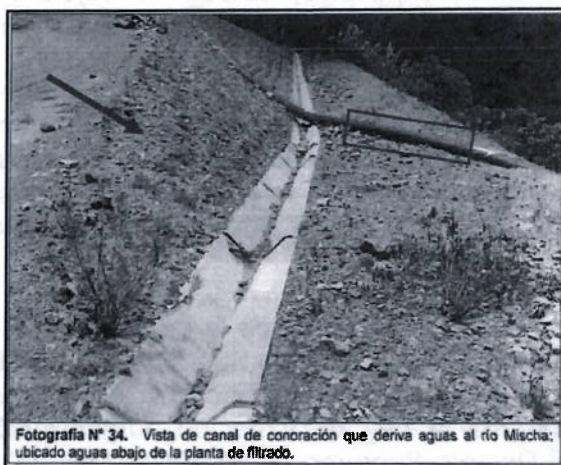
Cuneta de escorrentía de aguas de no contacto en la zona de la Planta
