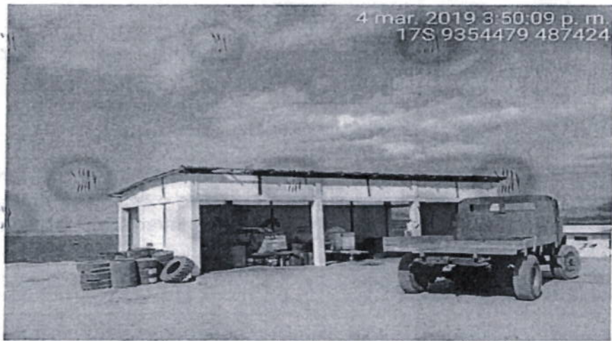
Almacén de combustible (Gasolina y petróleo)
