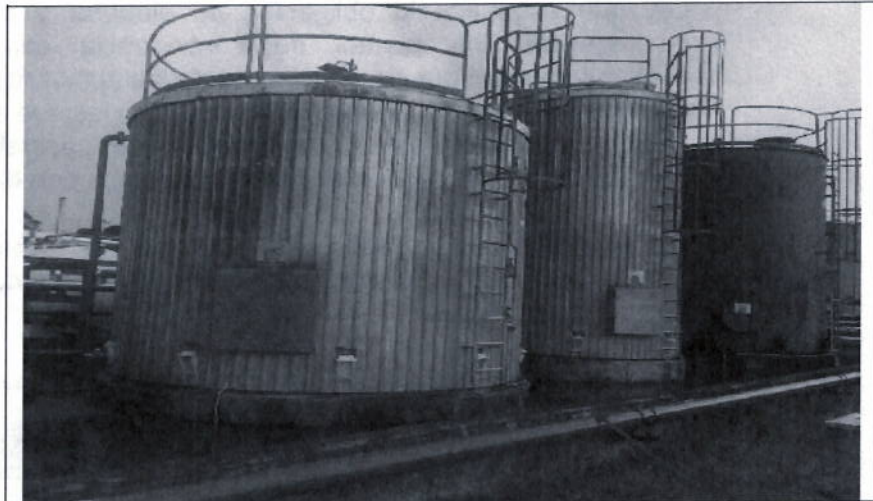
Muro de contención en la zona de tanques. Coordenadas: 9577572N; 0493055E. Fecha: 12/12/2017
