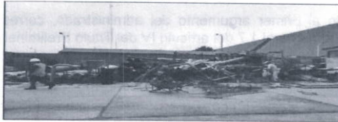
Foto 1: Efectuando clasificación de desechos en la zona de la chatarra formada
