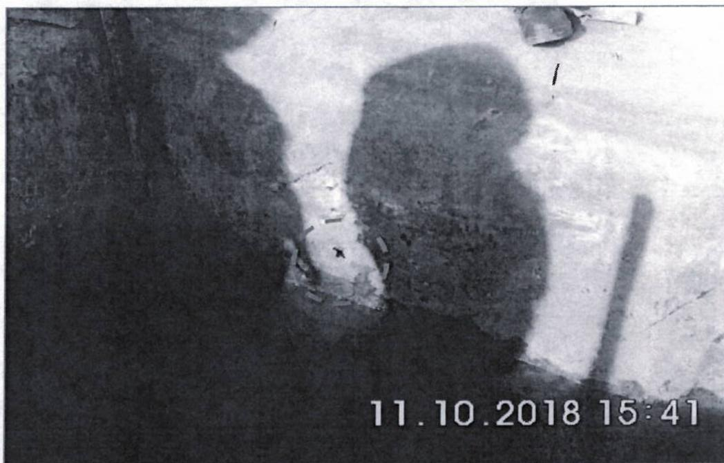
Fotografía N° 20: Vista de la geomembrana deteriorada (agujero) en la tercera poza de tratamiento para los drenajes ácidos del Depósito de Relaves N° 5.
