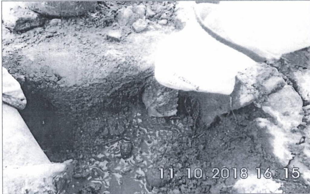
Fotografía N° 26: Vista de la filtración proveniente de la tubería de la poza de secado de lodos.
