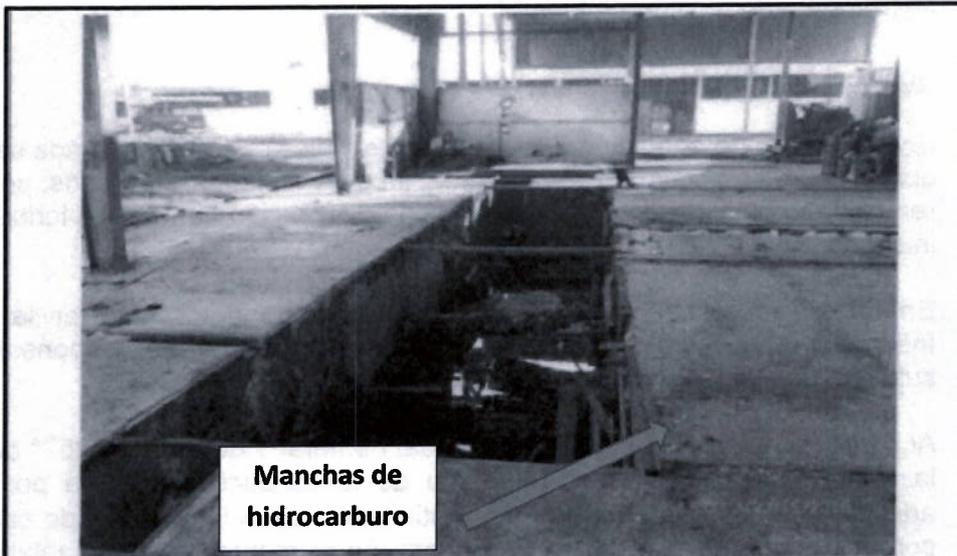
Fotografía N° 2: Vista del interior de la sala de máquinas, se evidencia que los equipos y sistemas electromecánicos fueron desmontados y retirados del lugar. Algunos accesorios se encuentran embalados en caja de maderas y otros dispuestos en estanterías. También se aprecia la acumulación de fluidos con mezcla de elementos oleosos e hidrocarburos.
