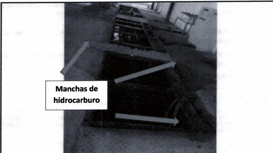
Fotografía N° 4: Vista de las canaletas de cable fuerza, donde los cableados fueron retirados. El fondo y la pared de las canaletas tendrán que ser demolidas según lo previsto en el Plan de Abandono. Al fondo de las canaletas se aprecia lodos con mezcla de hidrocarburos.
