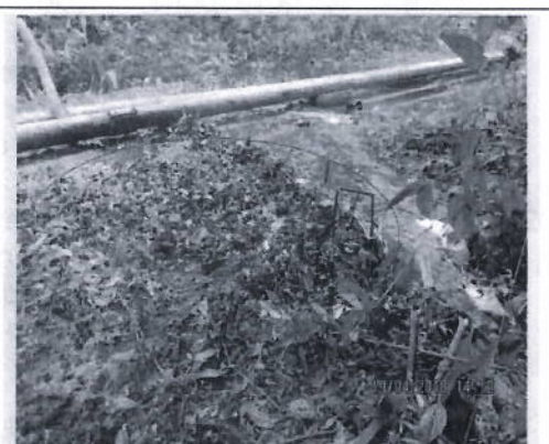
Fotografía N° 2 Área afectada por el derrame en terreno firme. Coordenadas UTM-WGS 84: 9738478N, 403869E
