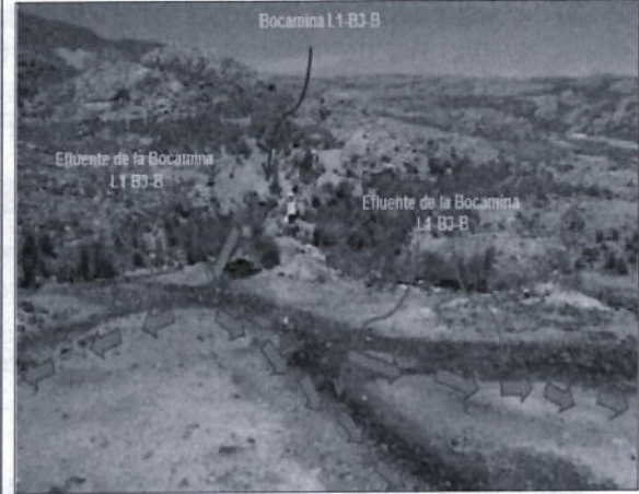
Vista panorámica de la Bocamina L1-B3-B, se observa vegetación por sus bordes y su efluente de color naranja oscuro que discurre cuesta abajo en dirección al depósito de desmonte L1-D7-B.
