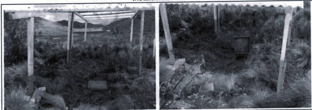
Instalación de techo
