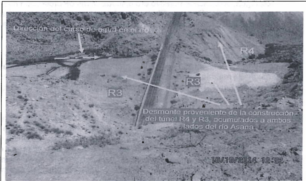
Fotografía N° 101: Transporte de relaves Concentradora Botiflaca – Quebrada Cimarrona. Cruce del río Asana, el desmote proveniente de la construcción del túnel R3 – lado sur y R4 – lado norte, se encuentran almacenados en ambas orillas del río Asana.
