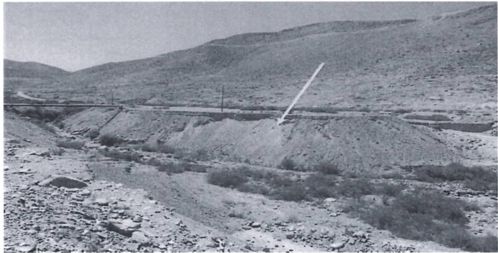
Fotografía N° 87: Transporte de relaves Concentradora Botiflaca – Quebrada Cimarrona. El talud de pie de los desmontes almacenados en ambos lados del curso de agua de la quebrada Cocotea, no tienen ningún sistema de protección para evitar la erosión y arrastre de desmorte por las crecidas de agua.
