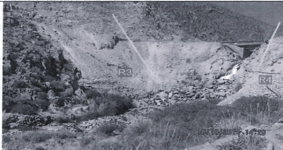
Fotografía N° 101: Transporte de relaves Concentradora Botiflaca – Quebrada Cimarrona. Cruce del río Asana, el desmote proveniente de la construcción del túnel R3 – lado sur y R4 – lado norte, se encuentran almacenados en ambas orillas del río Asana.
