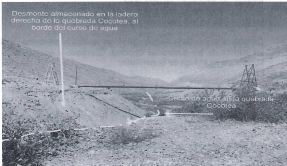
Fotografía N° 85: Transporte de relaves Concentradora Botiflaca – Quebrada Cimarrona. Vista de cruce del canal de conducción de relaves y tubería de conducción de solución PLS de cobre por la quebrada Cocotea. Los desmontes generados en la construcción de los túneles están almacenados en ambas laceras de la quebrada Cocotea.
