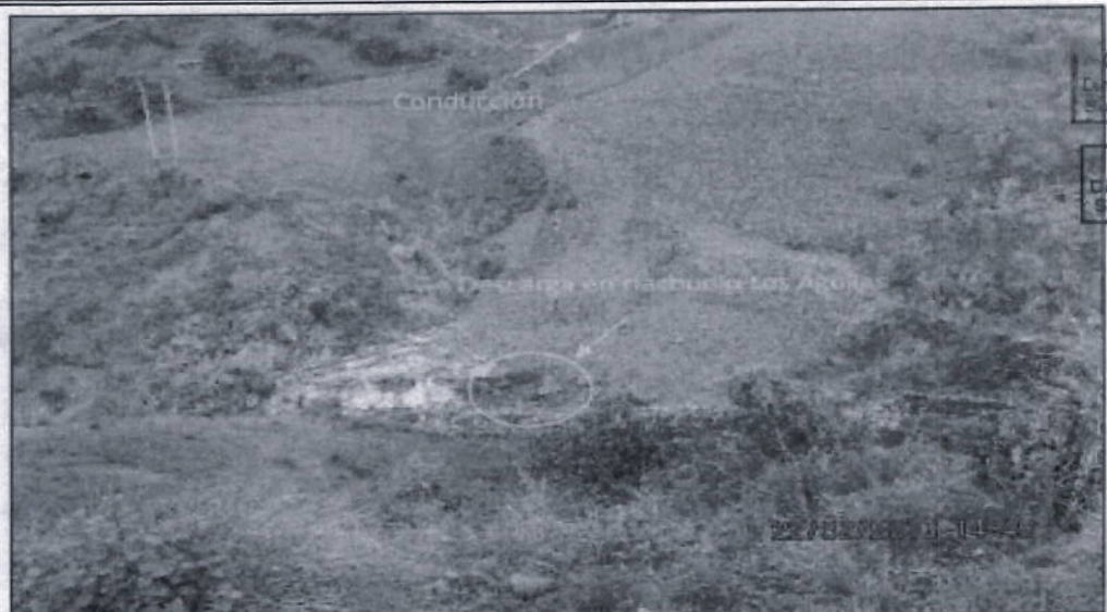
Fotografía N° 31. Las aguas provenientes de la poza de lodos inferior del tajo El Zorro son captadas mediante una tubería que las conduce hasta el punto de descarga en el riachuelo Las Águilas. COORDENADAS UTM WGS84: 9253040N, 760917E, ZONA 17. Hallazgo N° 01.
