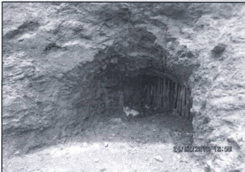
Fotografía N° 50. Bocamina nivel 3680. COORDENADAS UTM WGS84: 9252911N, 761493E, ZONA 17. Hallazgo N° 02.
