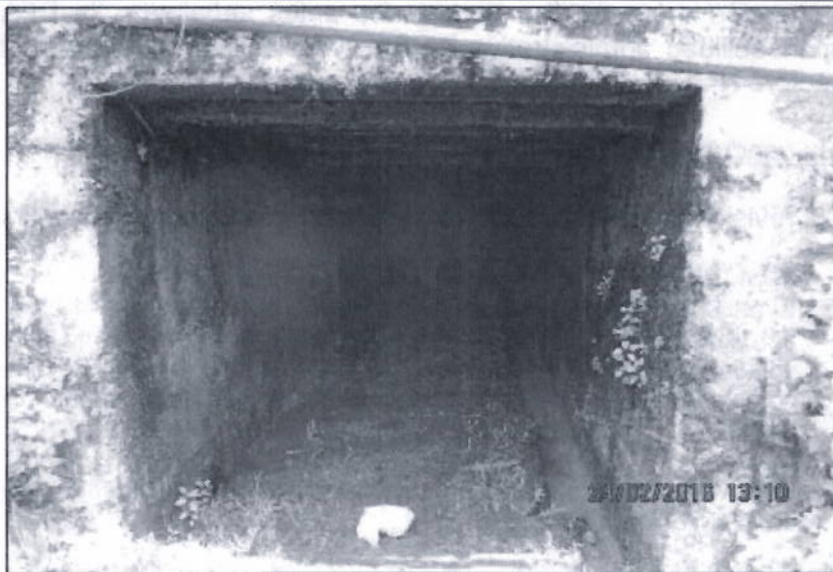
Fotografía N° 24. Bocamina ubicada en la zona de campamentos, las aguas provenientes de esta son captadas mediante un canal de derivación que conduce las aguas a lo largo del acceso hacia la parte superior del tajo El Zorro, donde son descargadas. COORDENADAS UTM WGS84: 9252798N, 761455E, ZONA 17. Hallazgo N° 01 y N° 02.
