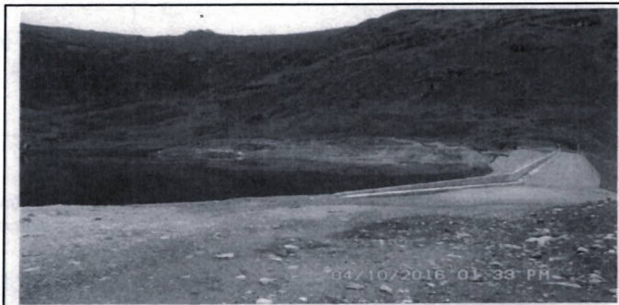
Fotografía 5-2. Vista de la presa Huangush Bajo y del área de suelo removida en un área aproximada de 3,000.00 m 2 .
