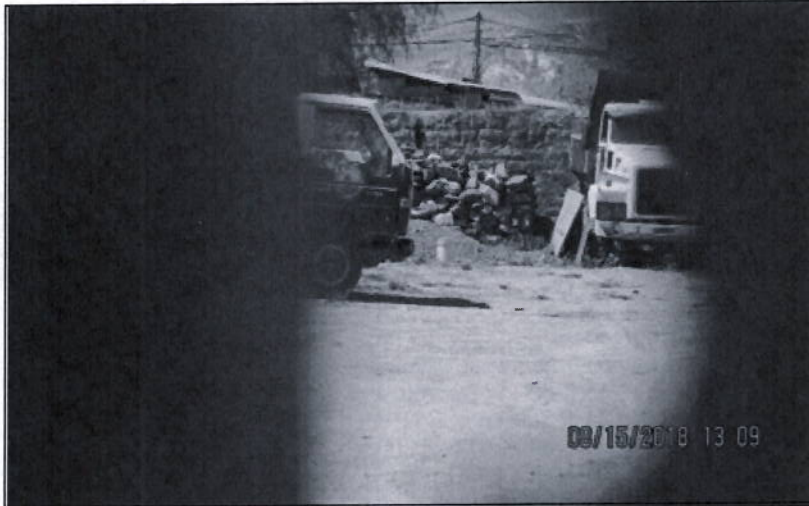
Fotografía N° 10. Vista ampliada, tomada desde la ranura del portón de ingreso, donde se visualiza que al interior hay dos camiones y piedras acumuladas en el suelo. Asimismo, se identifica que el suelo al interior no está pavimentado y no cuenta con techo.
