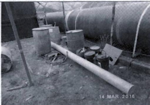
Fotografía H6-4. Compuestos químicos y recipientes con hidrocarburos (materiales) almacenados directamente sobre el suelo de tierra, sin sistema de contención secundaria, sin rotulación y a la intemperie, se observa también la tubería de color verde que se viene instalando bajo tierra.
