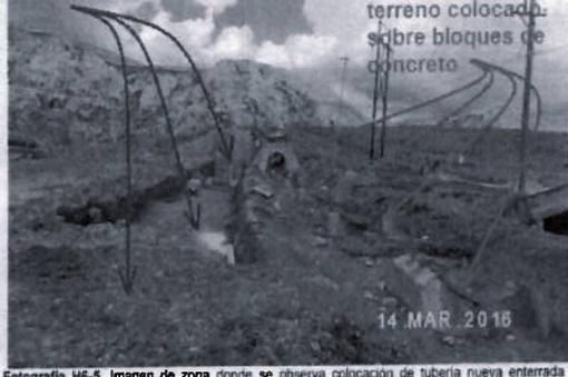
Fotografía H6-5. Imagen de zona donde se observa colocación de tubería nueva enterrada y tubería existente sobre el terreno que viene siendo retirado.
