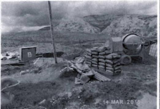
Fotografía H6-29. Frente de trabajo donde se viene haciendo uso de cemento, agregados y agua para la preparación del concreto que se viene usando en la construcción de cámaras y colocación de nuevas tuberías que son enterradas.
