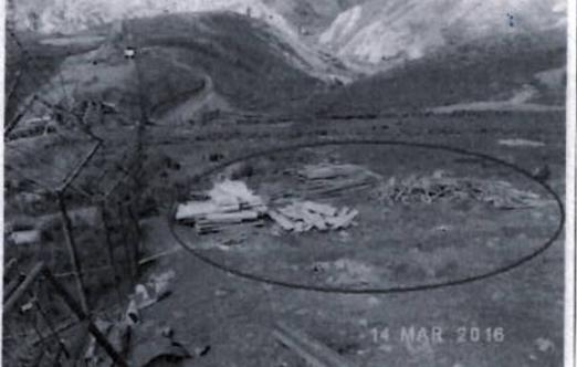
Fotografía H6-14. Tablas, palos, triplay sobre terreno natural con cobertura vegetal, dichos materiales vienen compactando el terreno, la zona ocupada esta fuera del cerco de malla.
