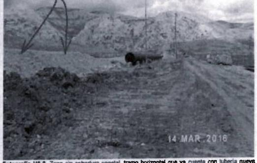
Fotografía H6-8. Zona sin cobertura vegetal, tramo horizontal que ya cuenta con tubería nueva cubierta con tierra, se observa tubería de color negro pendiente de retiro.
