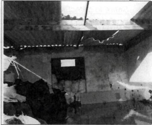
Fotografía N° 7.08-A: Almacén temporal de residuos peligrosos (tierra contaminada con hidrocarburos). En su interior se encuentra inundada con agua de lluvia debido a que el almacén no se encuentra completamente techado.
