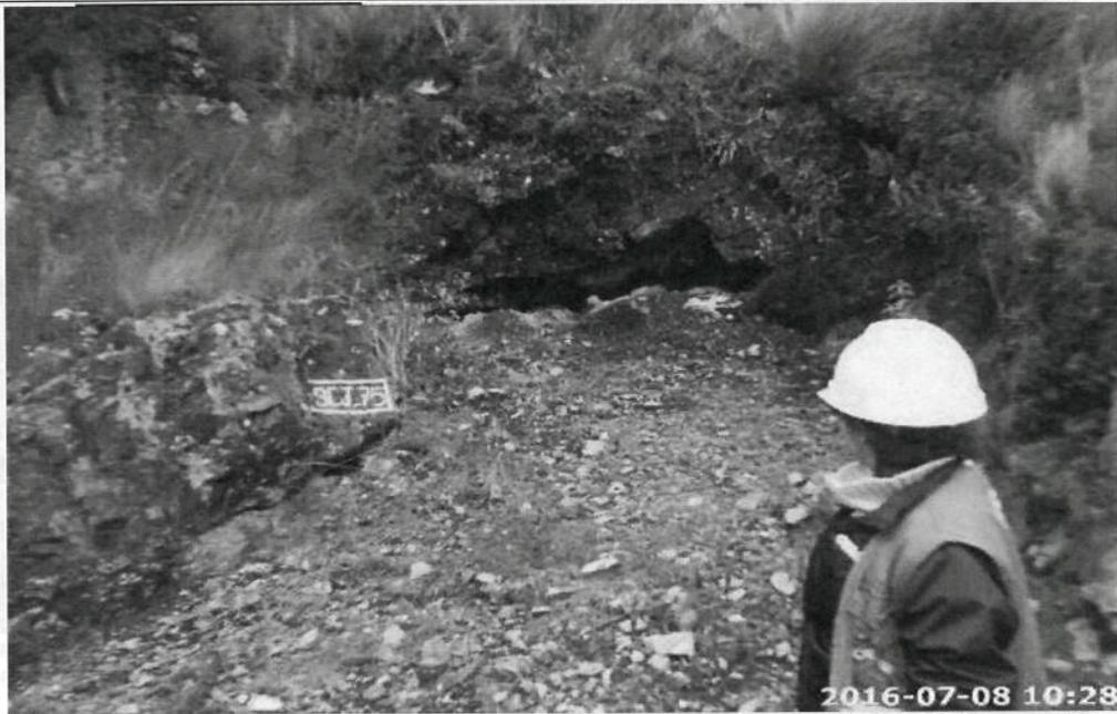
Fotografía N° 1: Vista fotográfica de la bocamina BCJ-75, ubicado en las coordenadas geográficas UTM WGS84 N 9252340, E 763975. Se encuentra cubierta con tierra y fragmentos de roca.
