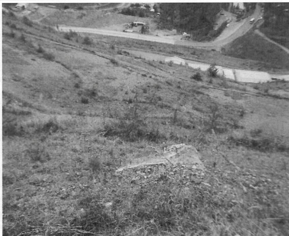
**Fotografía N° 389: Hallazgo de gabinete N° 13.** - Se observó que el depósito de desmonte DD BSA-100, no ha sido revegetado. No presentaba canales intermedios con muros de gaviones.
