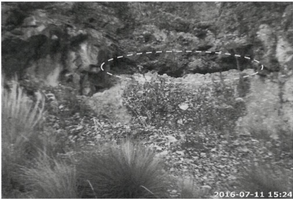
**Fotografía N° 111:** Vista fotográfica de la bocamina BCJ-35, ubicada en las coordenadas geográficas UTM WGS84 N 9252649, E 764191. Se observó que se ha dispuesto frente a la bocamina fragmentos de roca. No obstante, se observó que la bocamina presenta una abertura.
