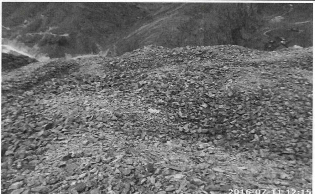
Fotografía N° 373: **Hallazgo 9:** Se observó que el depósito de desmonte DD CJ-4, no ha sido revegetado.
