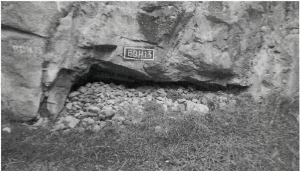
**Fotografía N° 347: Hallazgo 2:** Se observó que la bocamina con códigos BQH-13 presentaba una abertura en la parte superior, a través de la cual no se logró distinguir si ésta contaba con tapón de concreto armado en el interior. No se observó arcilla ni tierra de cultivo utilizada para cubrir la bocamina.
