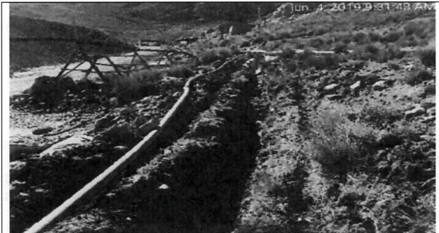
Imagen 01: Vista del Canal, se aprecia con el cauce limpio, seco y la vegetación en buen estado.
