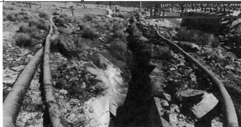
Imagen 03: Se aprecia parte del canal donde se viene colocando geomembrana. Para estas actividades se ha retirado el material de la base del canal y se dispuso en la relavera.
