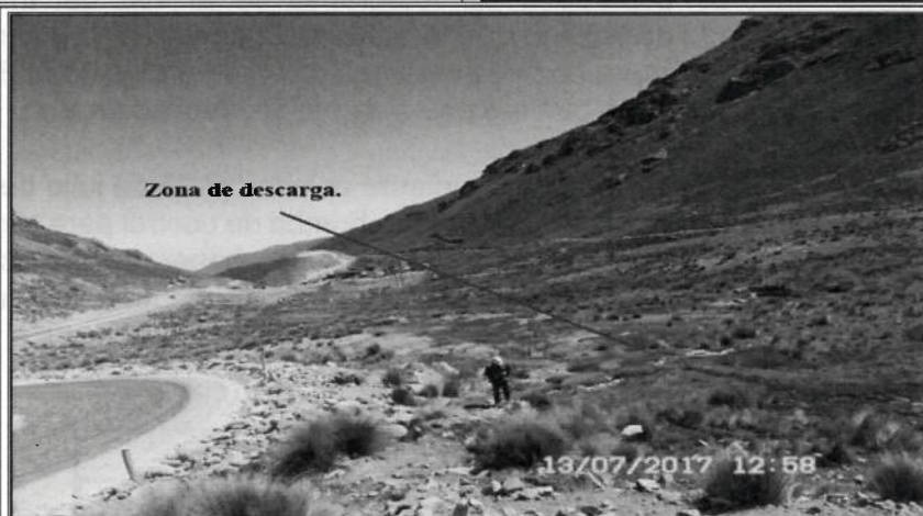
Fotografía N° 103. Presunto Incumplimiento N° 6: Zona de descarga del rebose de agua proveniente de la primera poza de sedimentación.
