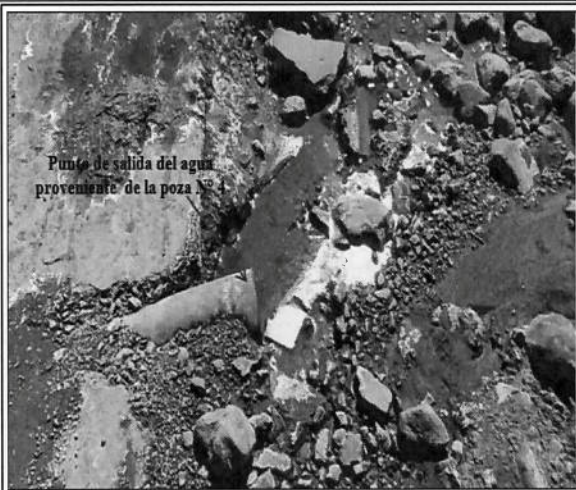
Fotografía N° 74. Presunto Incumplimiento N° 6: Vista del punto de salida del agua proveniente de la poza N°4 (Poza de Clarificación) que atraviesa una sección enterrada.
