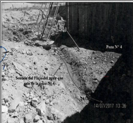
Fotografía N° 72. Presunto Incumplimiento N° 6: Vista del sentido del flujo de agua que sale de la poza N°4 (Poza de clarificación), el cual discurre por el suelo.
