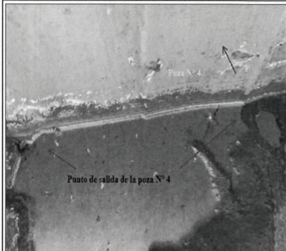
Fotografía N° 71. Presunto Incumplimiento N° 6: Vista del Punto de salida del agua de la poza N°4 (Poza de Clarificación)
