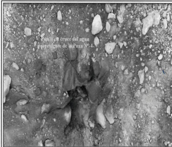
Fotografía N° 73. Presunto Incumplimiento N° 6: Vista del punto de ingreso del agua proveniente de la poza N°4 (Poza de Clarificación) que atraviesa una sección enterrada.
