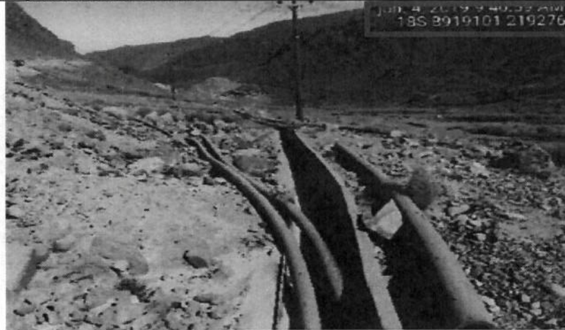
Imagen 02: Vista del mismo canal con concreto, se aprecia seco, no presentando desborde alguno.
