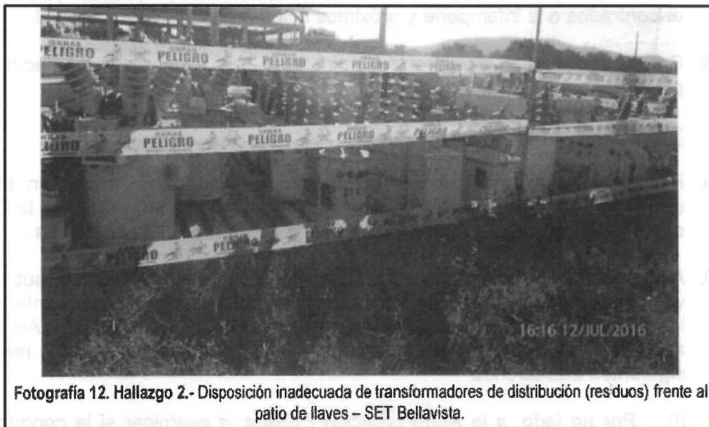
Fotografía 12. Hallazgo 2.- Disposición inadecuada de transformadores de distribución (residuos) frente al patio de llaves – SET Bellavista.
