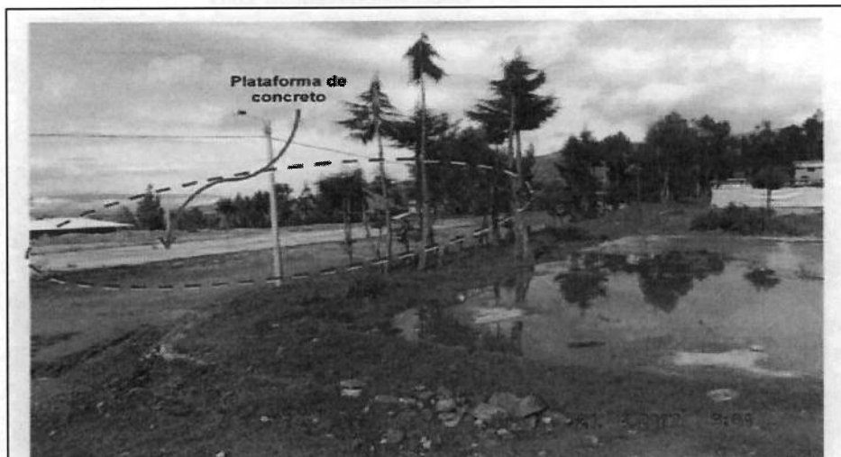
Fotografía N° 63: Vista panorámica de otro sector del campamento minero, donde se observa la segunda plataforma de concreto y por sus bordes una zona sin vegetación.
