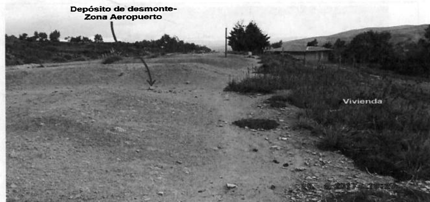
Fotografía N° 50: Otra vista del depósito de desmonte – zona Aeropuerto, ubicado en coordenadas UTM (WGS 84), E: 794703 N: 9221740, se observa la acumulación del material de desmonte, una vivienda cercana a este componente, y vegetación por sus bordes.
