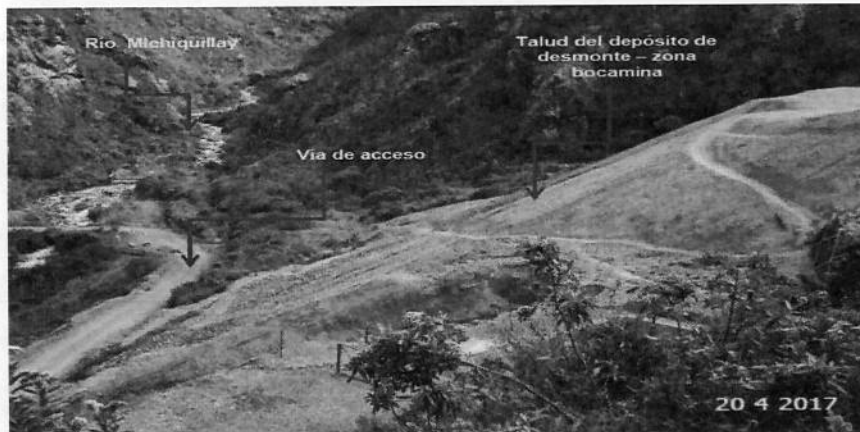
Fotografía N° 32: Vista del talud del depósito de desmonte – zona Bocamina, se observa que este componente se encuentra a un lado de la vía de acceso y margen izquierdo del rio Michiquillay., se observa, su proximidad a este cuerpo hídrico.
