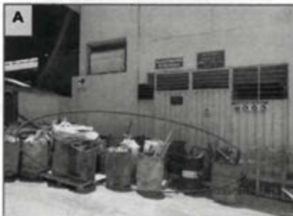
Foto N° 17A: En la imagen se aprecia la acumulación de residuos sólidos peligrosos y no peligrosos. Junto a la subestación eléctrica - anexo principal de la planta industrial. No cuenta con techo y el piso es de concreto, con pendiente negativa. No cuenta con una identificación, no se ha implementado un código de colores, no hay señalética, no está delimitada y no cuenta con sistema de contención, entre posibles escenarios de remediación de productos químicos generados por estar a la intemperie (temperatura, radiación solar, etc.).
