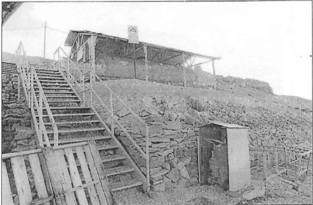
FOTO N° 7 HALLAZGO DE GABINETE Vista del almacén de combustible. Coordenadas (Datum GWS84) N 8385011, E 771411.
