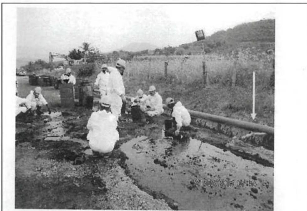
Foto N° 1: Vista del afloramiento de petróleo crudo en la carpeta asfáltica, cerca de la Progresiva 504 + 086 del Tramo II del Oleoducto Nor Peruano a la altura del Km 21 + 150 de la Carretera Bagua Imaza y de la tubería de 6" paralela a la cuneta. UTM WGS84: 770819 E, 9383532 N
