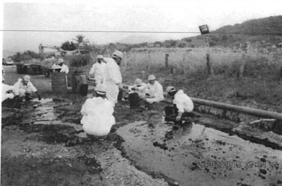
**Foto N°6** Vista de los trabajos de recojo de petróleo crudo en la carretera Bagua -Imaza Km 21 + 150.
