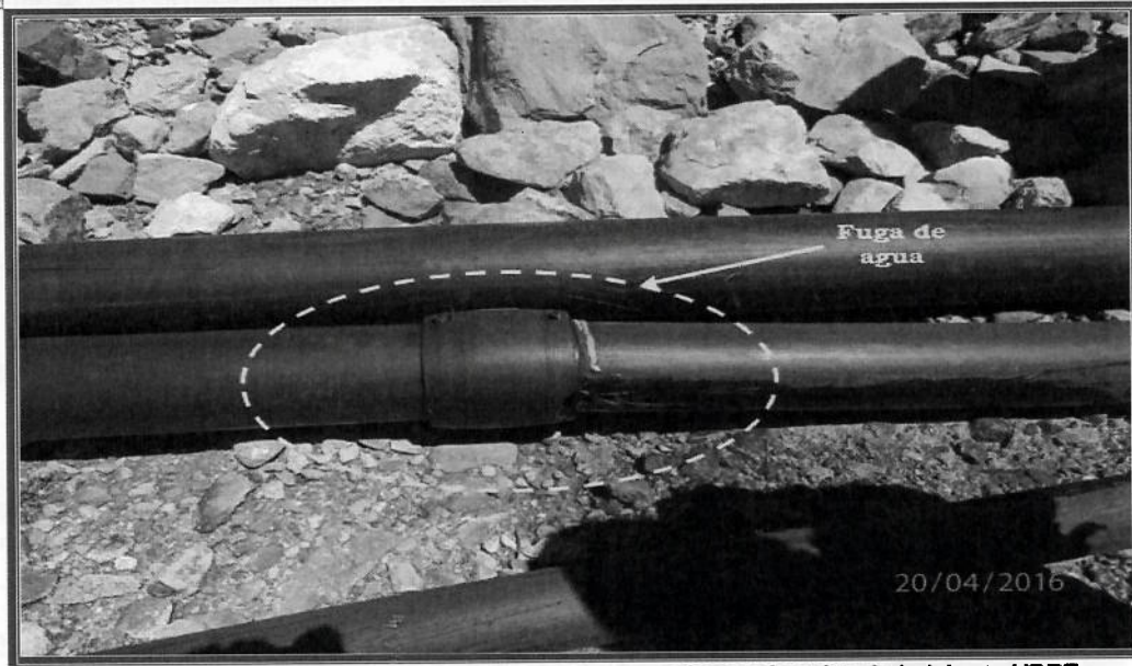
Fotografía N° 161: Hallazgo 14: Vista fotográfica donde se observa la unión de la tubería HDPE por donde existía la fuga de agua de mina, esto ubicado en las coordenadas UTM WGS 84 501433 E, 8555710 N.
