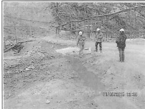
Fotografía N° 174. Hallazgo 04-2015. Botadero de desmonte P-SUR, vista de la llega de los drenajes a una poza de derivación de estos drenajes hacia la planta de neutralización.
