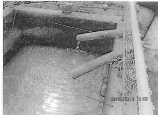
Fotografía N° 151. Hallazgo N° 06-2015, vista de las huellas del presunto nivel alcanzado por las aguas ácidas en la poza de concreto.
