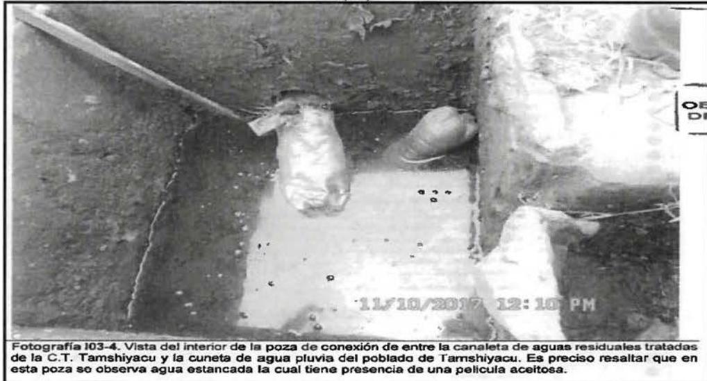
Fotografía 103-4. Vista del interior de la poza de conexión de entre la canaleta de aguas residuales tratadas de la C.T. Tamshiyacu y la cuneta de agua lluvia del poblado de Tamshiyacu. Es preciso resaltar que en esta poza se observa agua estancada la cual tiene presencia de una película aceitosa.
