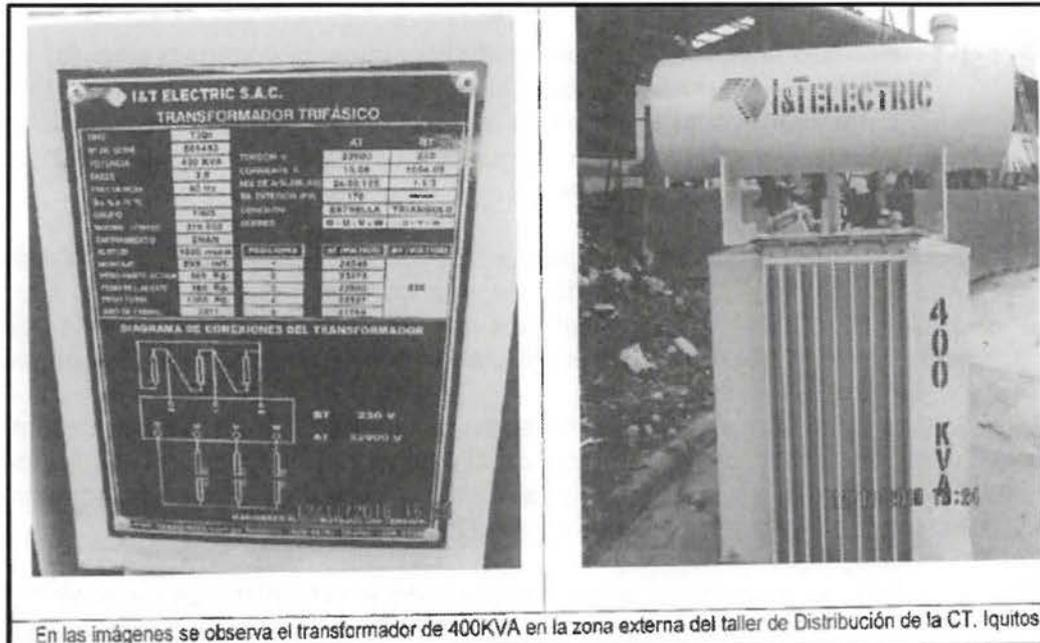
En las imágenes se observa el transformador de 400KVA en la zona externa del taller de Distribución de la CT. Iquitos
