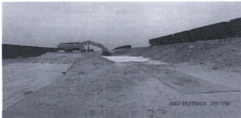
FOTOGRAFIA N° 03.- Desvío Coquina (Patio de maniobras) - Se constató una excavadora a sobre una rampa, el cual era usado para cargar los concentrados desde los vagones a los volquetes encapsulados.
