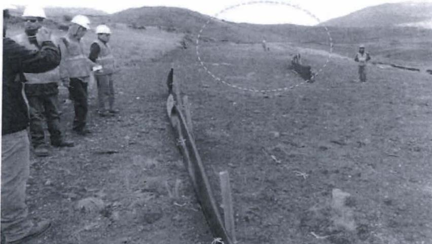
**Fotografía N° 6:** Se observa los cortos vientos, instalados sobre el suelo en proceso de restauración indicado línea arriba, al fondo el sondaje sin obturar.
