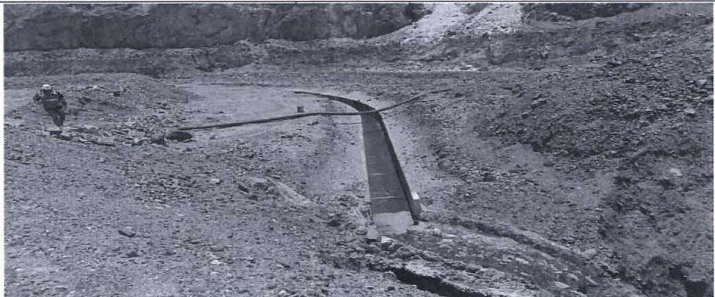
**Fotografía N° 163: Hallazgo N° 6: Se observa una línea de rebose, construido con concreto el cual conducía el agua de contacto proveniente de la poza de sedimentación del tajo Yanacocha Norte, este canal conducía el agua de contacto, hasta su descarga en el fondo del tajo.**
