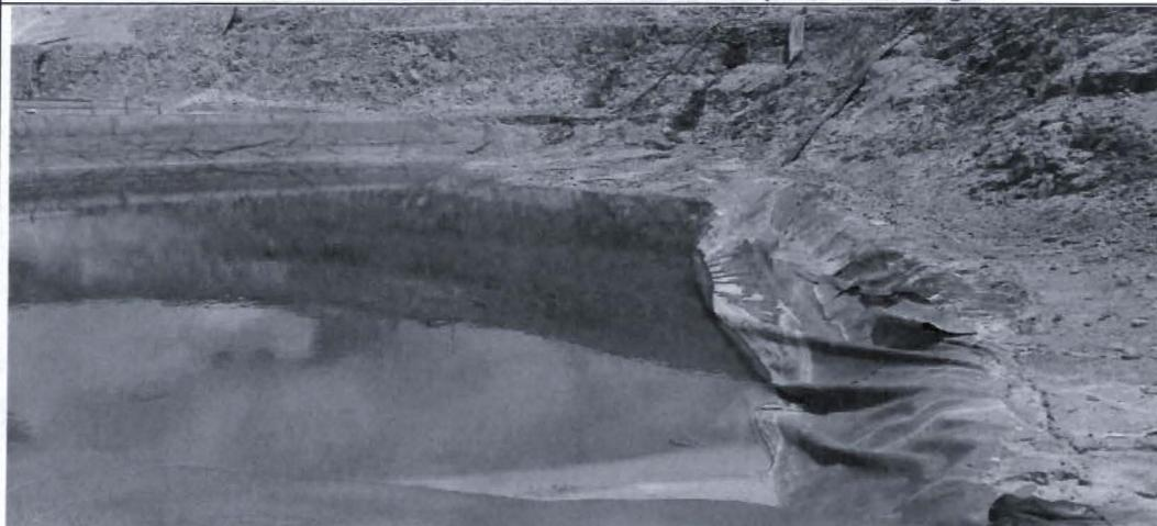
**Fotografía N° 159: Hallazgo N° 6: Se observó que el revestimiento de un lado de la poza de sedimentación de agua de contacto del Tajo Yanacocha Norte no se encontraba anclado, originando que el agua de contacto se infiltre por debajo de la poza. Coordenadas UTM Datum WGS84: 9227727 N y 774977 E.**
