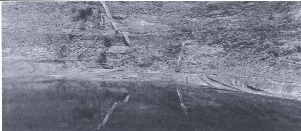
**Fotografía N° 160: Hallazgo N° 6: Vista del revestimiento de la poza de sedimentación de agua de contacto del Tajo Yanacocha Norte, la cual no se encontraba anclado.**
