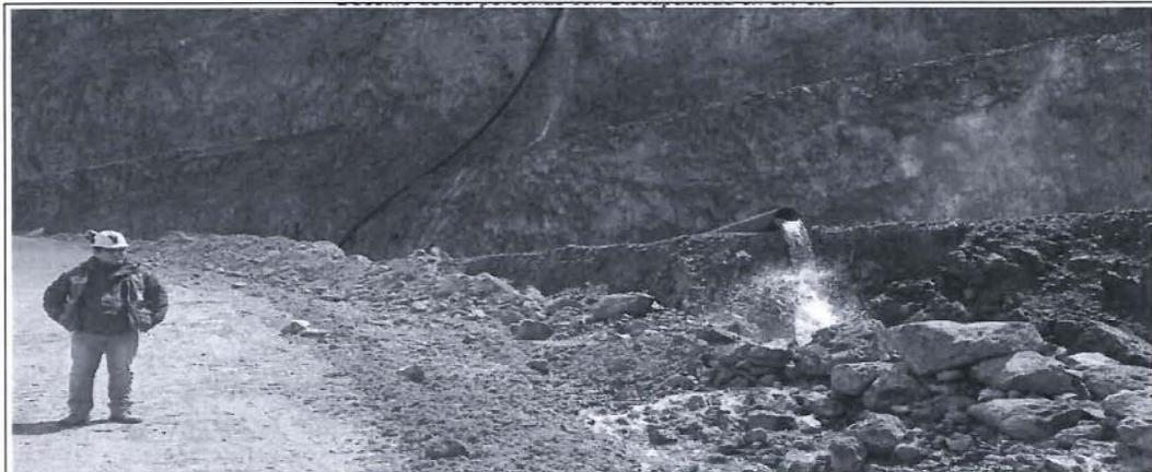
**Fotografía N° 154: Hallazgo N° 5:** En la parte baja del tajo Yanacocha Sur, se observó una tubería de HDPE de 6 pulgadas diámetro que conducía el agua de contacto de la poza de pre-tratamiento de Pampa Larga, esta tubería descargaba un flujo de agua con pH de 2.74 y un caudal de 22 l/s aproximadamente. Coordenadas UTM Datum WGS84: 9226867 N y 775104 E.
