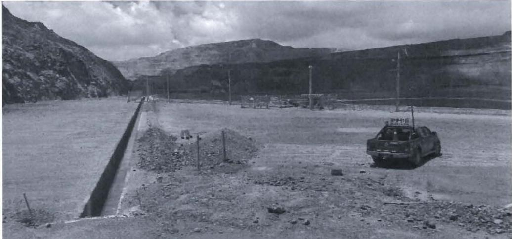
**Fotografía N° 162: Hallazgo N° 6: Se observa una línea de rebose, construido con concreto el cual conducía el agua de contacto proveniente de la poza de sedimentación del tajo Yanacocha Norte, este canal bordeaba la poza Margot N° 1.**
