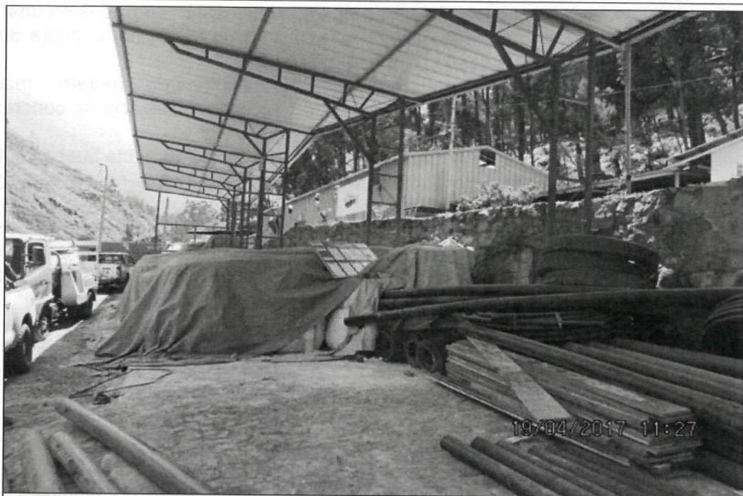
**Fotografía N° 136: Presunto Incumplimiento 2.-** Se constató que el depósito de almacenamiento de cal ocupaba un ambiente construido con piso de concreto, techado y sin cobertura lateral y frontal, en el que además se venían almacenando otros materiales tales como tubos, mangueras de HDPE, maderas, etc.;
