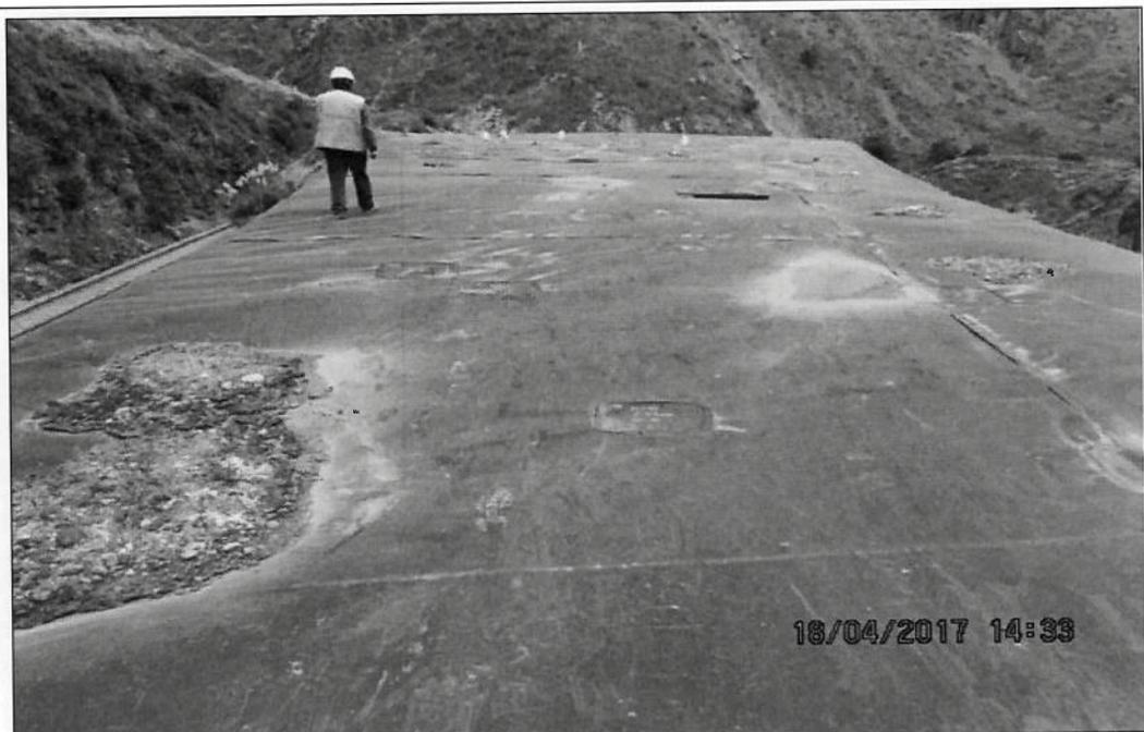
**Fotografía N° 81: Depósito de relaves Triana: Vista de la terraza del depósito cuyos relaves se encontraban encapsulados con geomembrana; no contaba con cobertura vegetal.**
