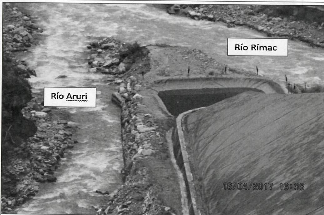
**Fotografía N° 75: Depósito de relaves Triana:** Se constató que este depósito cuyo Plan de Abandono fue aprobado mediante Resolución Directoral N° 156-97-EM/DGM del 18 de abril de 1997, era un depósito de aproximadamente 368 000 TMS de relaves que se encontraba ubicado en la margen izquierda del río Rímac, en el triángulo conformado por los ríos Rímac y Aruri y la línea férrea del ferrocarril central.
