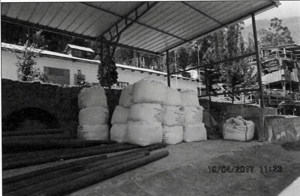
**Fotografía N° 130: Presunto Incumplimiento 2.-** Se constató que el depósito de almacenamiento de cal ocupaba un ambiente construido con piso de concreto, techado y sin cobertura lateral y frontal, en el que además se venían almacenando otros materiales tales como tubos, mangueras de HDPE, maderas, etc.;
