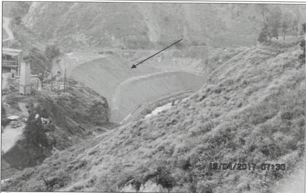
**Fotografía N° 74: Depósito de relaves Triana:** Se constató que este depósito cuyo Plan de Abandono fue aprobado mediante Resolución Directoral N° 156-97-EM/DGM del 18 de abril de 1997, era un depósito de aproximadamente 368 000 TMS de relaves que se encontraba ubicado en la margen izquierda del río Rímac, en el triángulo conformado por los ríos Rímac y Aruri y la línea férrea del ferrocarril central.
