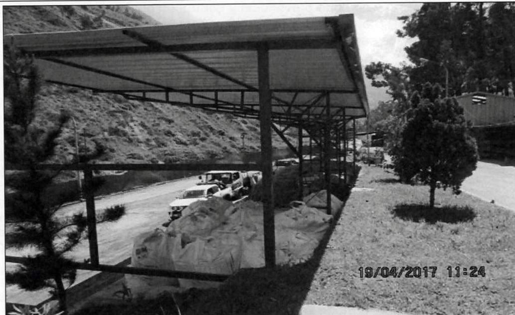
**Fotografía N° 133: Presunto Incumplimiento 2.-** La cal almacenada en bolsas big bag de 1000 kg cada una se encontraba dispuesta en el piso, sin protección contra el humedecimiento en las partes lateral y frontal, y sin contar con un sistema de contención contra derrames.
