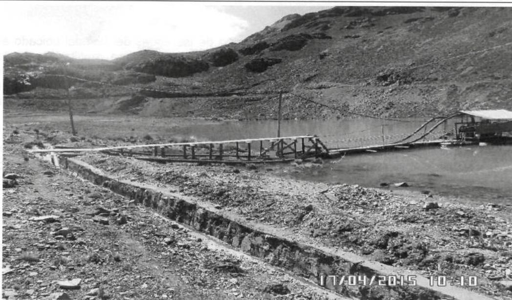
**FOTO N° 78: Tuberías instaladas desde la barcaza de bombeo de las aguas del espejo de agua del depósito de relaves Chinchán hacia el canal de mampostería que colecta y receptiona las aguas superficiales**
