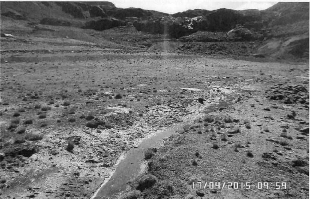
**FOTO N° 73: Inicio del canal excavado en suelo natural (aguas arriba del depósito de relaves Chinchán), que colecta y conduce las aguas superficiales hacia una poza denominada "poza de derivación"**
