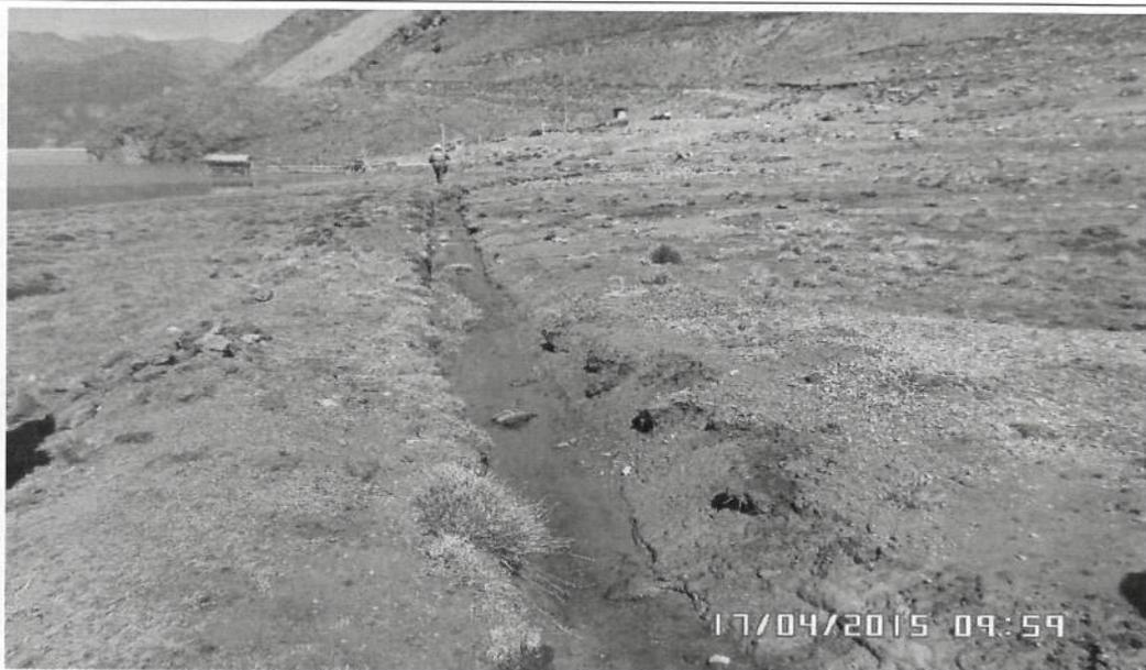
**FOTO N° 74: Continuación del canal excavado en suelo natural (aguas arriba del depósito de relaves Chinchán), que colecta y conduce las aguas superficiales hacia una poza denominada “poza de derivación”**
