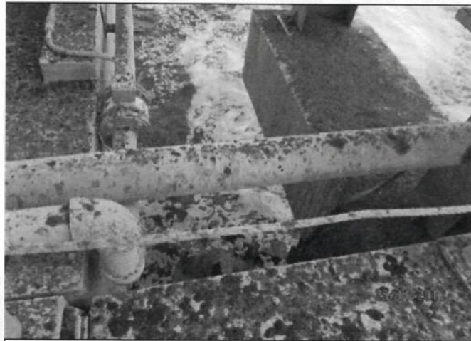
Fotografía N° 99. Hallazgo N° 3.- Vista de concentrado húmedo en el borde del muelle ubicado en la zona de transferencia de la faja transportadora CT 1 y CT 2; ante la caída de concentrado, parte de este caería directamente hacia el agua del mar.
