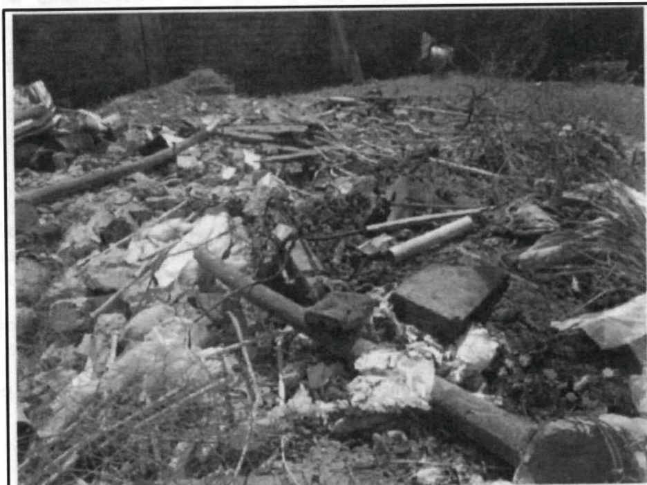
Fotografía N° 5: Se observa otra vista de la disposición (acumulación) de los residuos y escombros dentro de las instalaciones de la CT Juanjui, donde se realizaron acciones de quema, apreciándose los restos de madera, botellas plásticas, bolsas de concreto y aditivos, alambres, ramas, entre otros.
