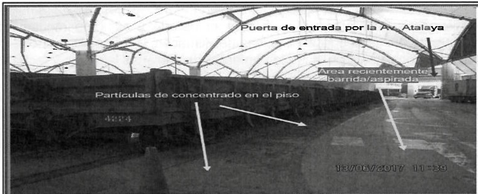
Fotografía N° 7: Área de recepción de vagones cargados. Vagones tipo góndola estacionados en el interior del almacén Comin I , en espera antes del ingreso a la balanza y descarga de concentrados. En el piso, cerca al vagón se observa partículas de concentrados que podrían ser arrastrados por las ráfagas de viento que ingresan por la puerta de entrada.
