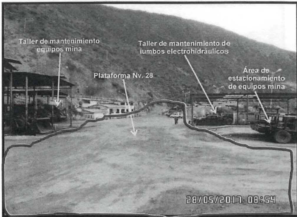
FOTOGRAFÍA N° 4d (Presunto Incumplimiento N° 02): Superficie de la plataforma del Nv. 28, donde se encuentran ubicados la oficina de la central de operaciones, taller de mantenimiento equipos mina, taller de mantenimiento de jumbos electrohidráulicos y área de estacionamiento de equipos mina.
