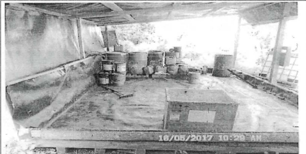
Fotografía 102-2. Vista del interior del almacén de residuos peligrosos en el que se pueden observar cilindros, baldes y galoneras acopiados, los cuales en su mayoría se encuentran con contenido de residuos líquido peligroso. Asimismo, se señala la zona en la cual existe un traslape entre geomembranas lo cual no ofrecería impermeabilización en caso de fugas y/o derrames. Es preciso mencionar que este almacén se encuentra rodeado de vegetación.
