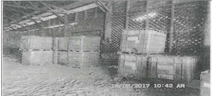
Fotografía 101-5. Vista del interior del almacén general, en esta fotografía se puede observar el almacenamiento de 11 tanques de combustible sobre suelo descubierto y sin ningún sistema de contención en caso de fugas y/o derrames. Es preciso resaltar que, tal como se mencionó en la fotografía anterior, en la parte posterior existe vegetación circundante la cual podría ser afectada en caso de derrames mayores ya que la pared de madera que se observa tampoco ofrecería impermeabilización.
