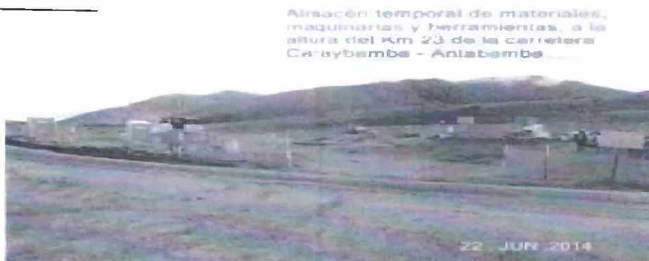
Imagen 01. Se observa zona utilizada como almacén temporal en zona cercana al Km 23 de la carretera Caraybamba - Antabamba
