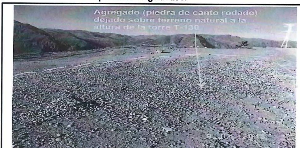
Vista 11. Agregados utilizados en los trabajos civiles de construcción de la base de la torre, dispersos en 36 m 2 aproximadamente sobre terreno natural.
