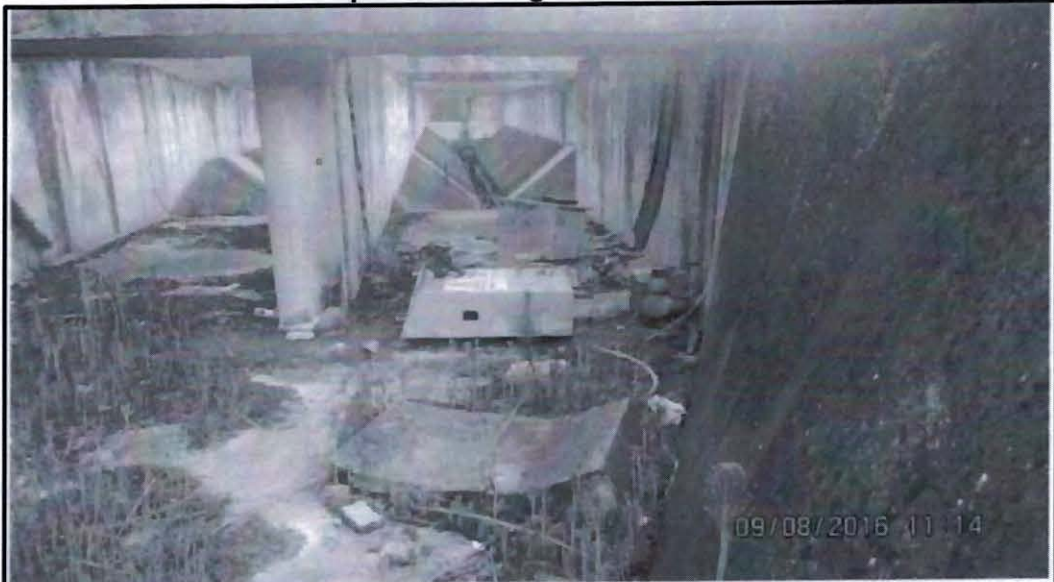
Fotografía N° H02-C: Vista de los residuos peligrosos y no peligrosos dispuestos a granel sobre suelo directo, ubicados en los ex desarenadores de la C.H. Cáliz, coordenadas UTM WGS 84, 178248E 9314587N.
