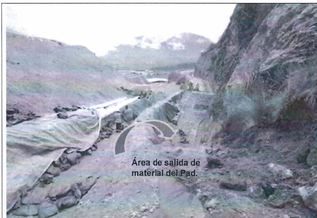
Fotografía N° 50: Se observó material del Pad de lixiviación pegado a la berma de contención, asimismo se constató que dicho material se encontraba fuera de la mencionada berma. Coordenadas UTM Datum WGS84: 8951826 N y 215340 E.
