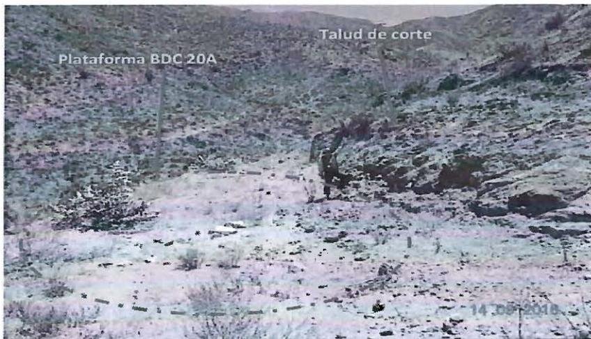
**Fotografía N° 022:** Vista fotográfica de la plataforma de perforación con sondaje BDC 20A. Nótese el talud de corte de aproximadamente 2 m y la menor densidad de vegetación en comparación con el entorno.
