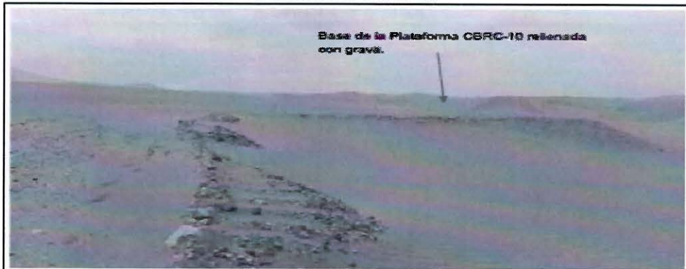
Fotografía N° 29: Vista de la plataforma CBRC-10 ubicada en las coordenadas UTM WGS84 Zona 18: E 523 506, N 8 322 033. Se observó la plataforma rellena con grava. No se observó sondaje. Cabe mencionar que el área circundante es una zona arenosa.
