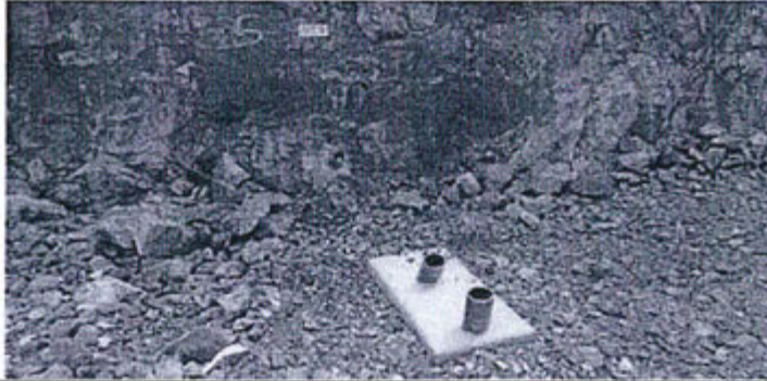
Foto 6: Plataforma SC-5, después (quedan 3 sondajes)
