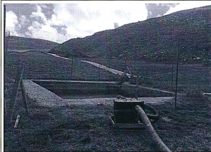
Se puede observar que en dicha poza se ha instalado un cerco metálico y se ha acondicionado un sistema de Bombeo de las aguas de contacto, que luego son enviadas hacia La Mina
