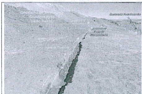
Fotografía N° 61 (contenida en el anexo N° 5 del Informe Preliminar). Hallazgo N° 7.- En el lado oeste del Depósito de Desmonte Condorcayán, se observó que el agua de subdrenaje proveniente de dicho Depósito es captada y direccionada por canales hacia una poza de mampostería. Luego se descarga sobre el suelo para finalmente llegar a la quebrada Huachuacaja.
