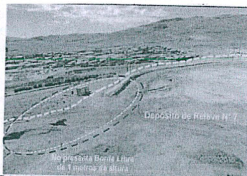
Fotografía N° 68 (contenida en el anexo N° 5 del Informe Preliminar) Hallazgo N° 8.- Vista panorámica de otro extremo del Deposito de Relave N° 7, en el que se aprecia inexistencia del borde libre.
