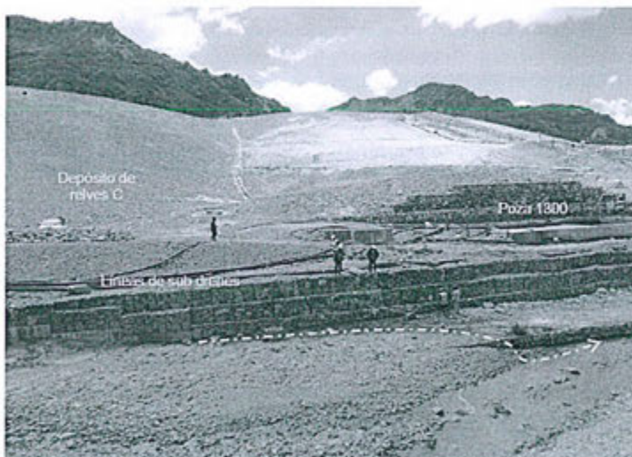
Fotografía N° 20: Se observa la parte baja del Depósito de relaves C, donde se acumulaba agua, la cual fluía hasta río Escalera (coordenadas UTM WGS 84 N8555958, E501472).
