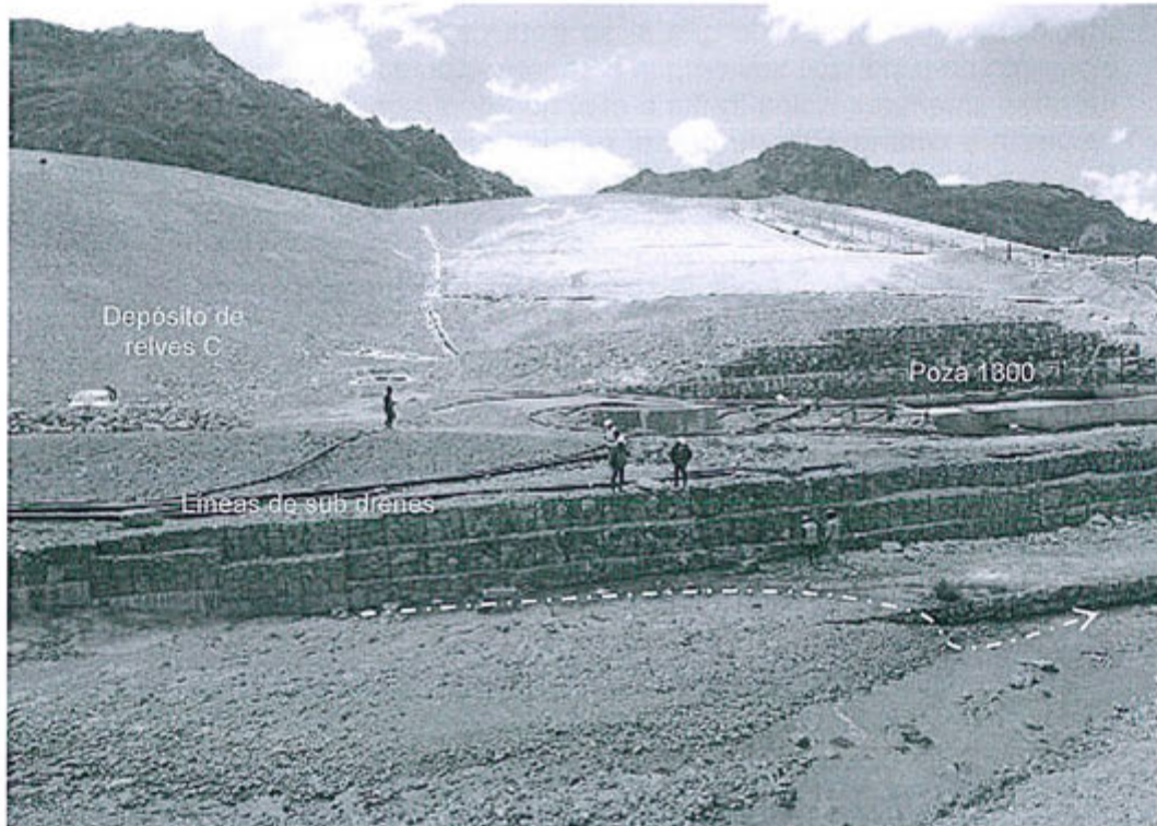
Fotografía N° 1: Se observa la parte baja del Depósito de relaves C, donde se acumulaba agua, la cual fluía hasta río Escalera (coordenadas UTM WGS 84 N8555958, E501472).
