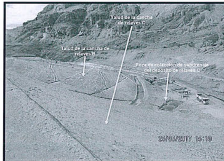
FOTOGRAFÍA N° 43: Vista de los taludes de las canchas de relaves B y C; se observa la poza colección de subdrenaje y escorrentías de la cancha de relaves C ubicada al pie del talud del dique de contención de la cancha en mención.
