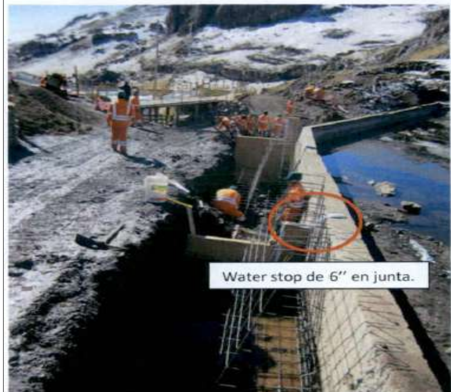
Fotografía 5: Encofrado y colocación de wáter stop de 6" en juntas.
